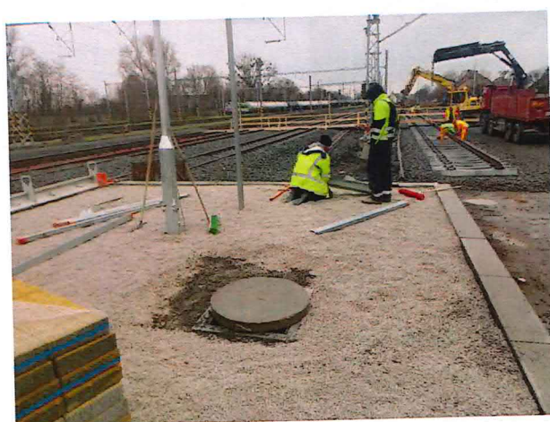
02-32-06 Podkladné vrstvy pod dlažbu, výšková úprava šácht
