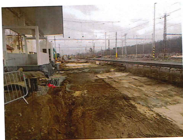
02-32-02 Odkopy, odsun kolidujúcich káblov
