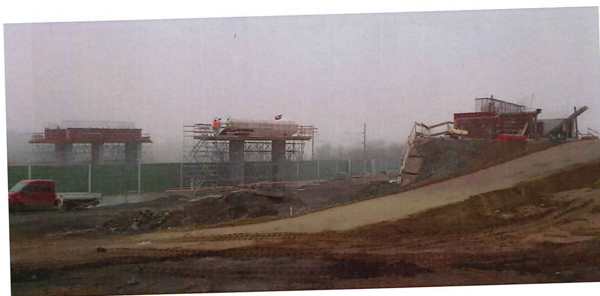
01-33-06 Armovanie, debnenie a betonáž úložných prahov
