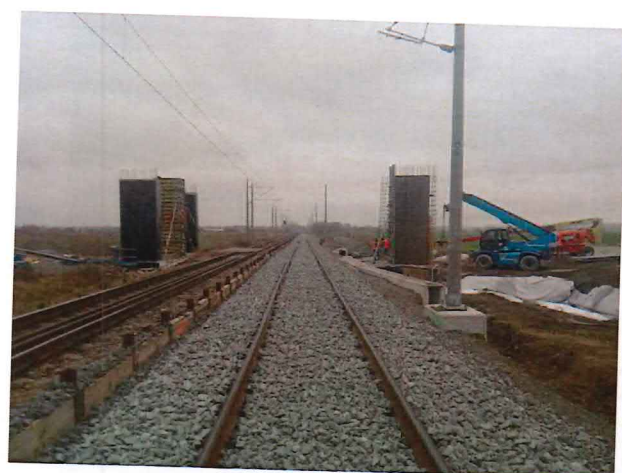
01-33-13 Armovanie a debnenie driekov opory
