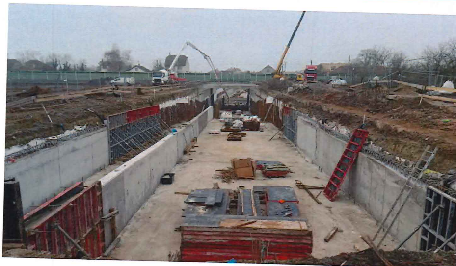
11-33-06 Betonáž tesniacej vane
