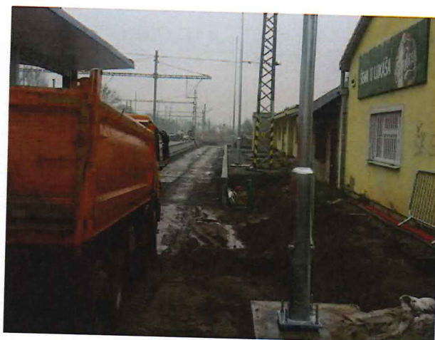
02-05-08 Montáž stožiarov osvetlenia
