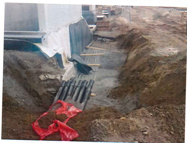
02-34-02 Pokládka rúr kábelovodu
